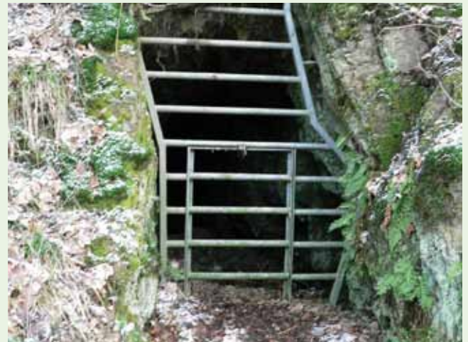
Alter Stollen mit speziellem Fledermausgittertor
